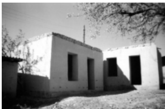
5-расм. Наманган вилоятининг Уйчи ғишт заводи ҳудудида темирбетон ўзак билан кучайтирилган мустаҳкамлиги кичик материаллардан қурилган уйлар: чапда-яхлит глинали; ўнгда- хом
