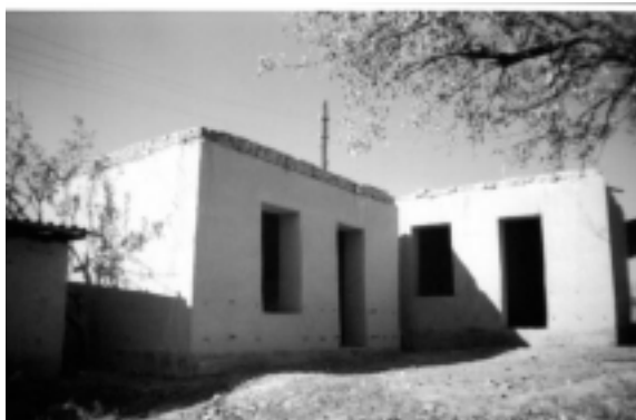
Рис.5. Экспериментальные дома из малопрочных материалов, усиленные железобетонными сердечниками на территории Уйчинского кирпичного завода Наманганской области: слева-глинобитное;
