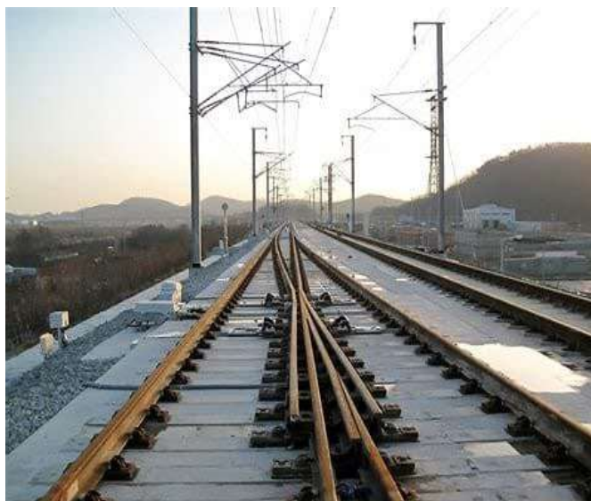
1-rasm foydalanishdagi temirbeton asosli strelkali o'tkazgich
